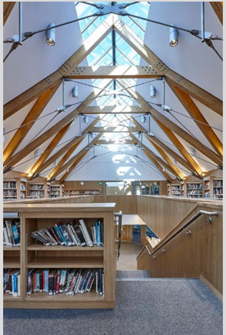
Bibliothèque - ROYAUME UNI - Plafond Acoustique Installation : ACOUSTIC GRG
